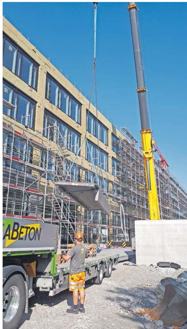
Montage der bis zu 6 Tonnen schweren Fassadenelemente
