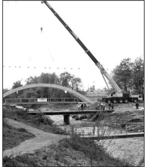
Millimeterarbeit beim Aufsetzen. Im Vordergrund Hilfsbrücke und alter Suhresteg.
