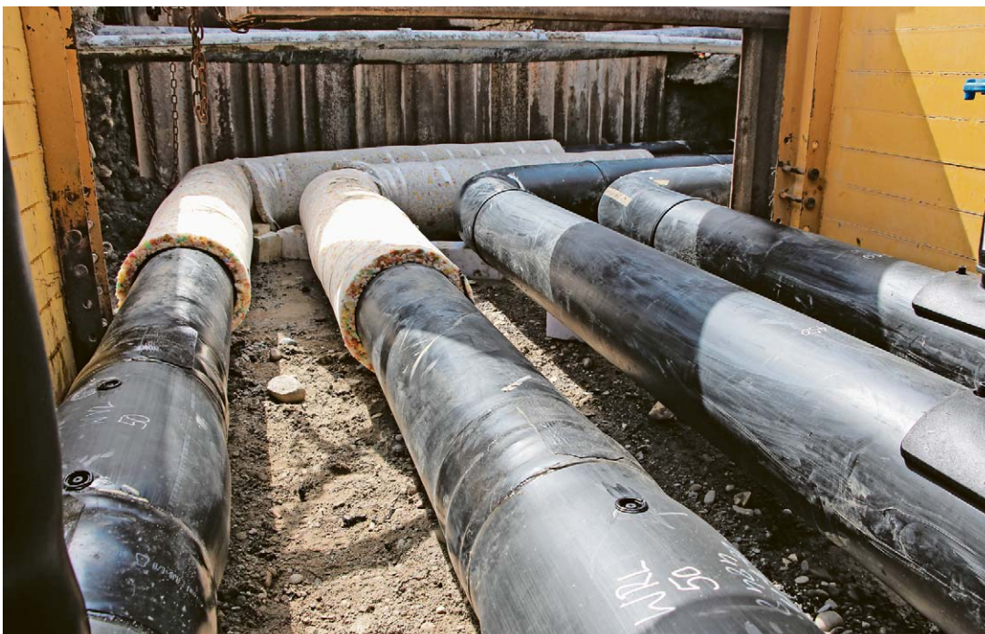
Fernwärme- und Fernkälteleitungen im Baustellengraben
